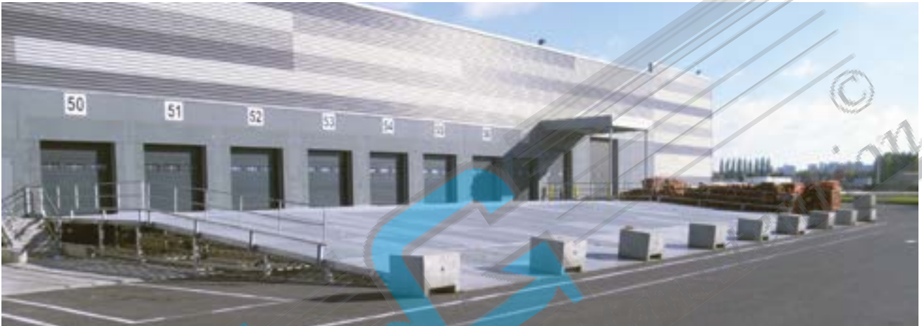
Rampe fixe, longueur 20 mètres sur 35 mètres de bâtiment servant au déchargement des camionnettes
